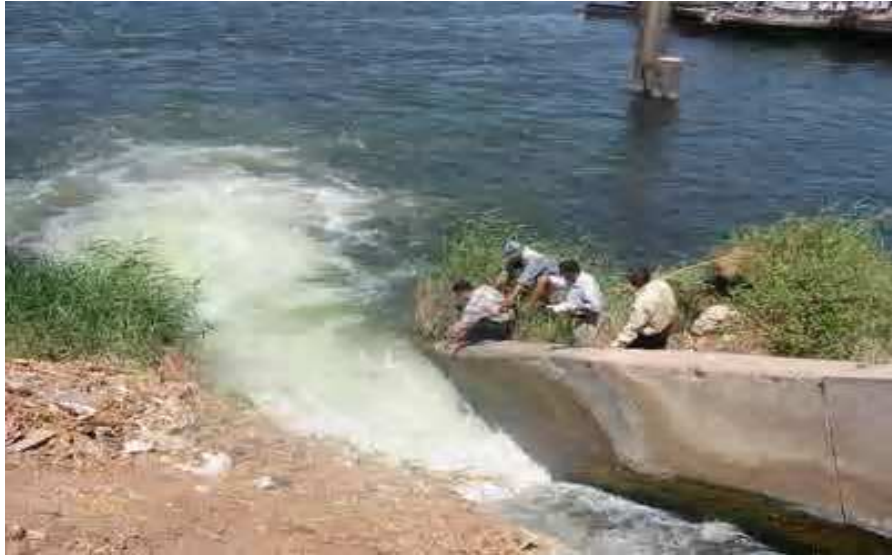
شكل (٤-٨) : صرف مياه التبريد من محطة كهرباء الحمراء على النيل مباشرة
