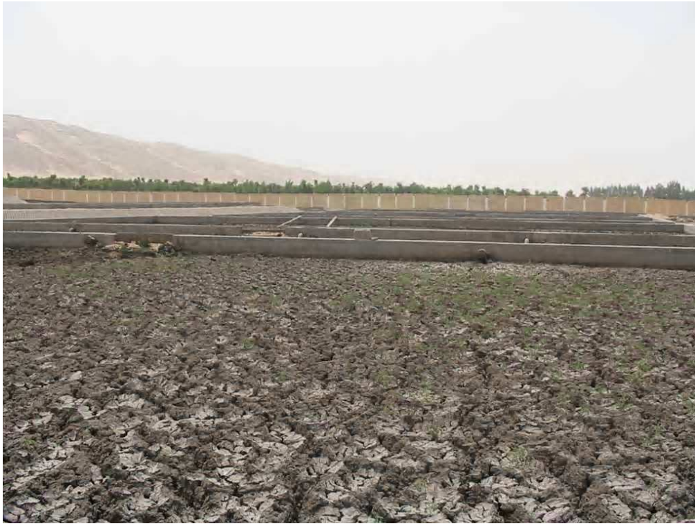
شكل (٥-٥): حوض تجفيف الحمأة لا يعمل بصورة منتظمة مما يظهر به من نباتات
