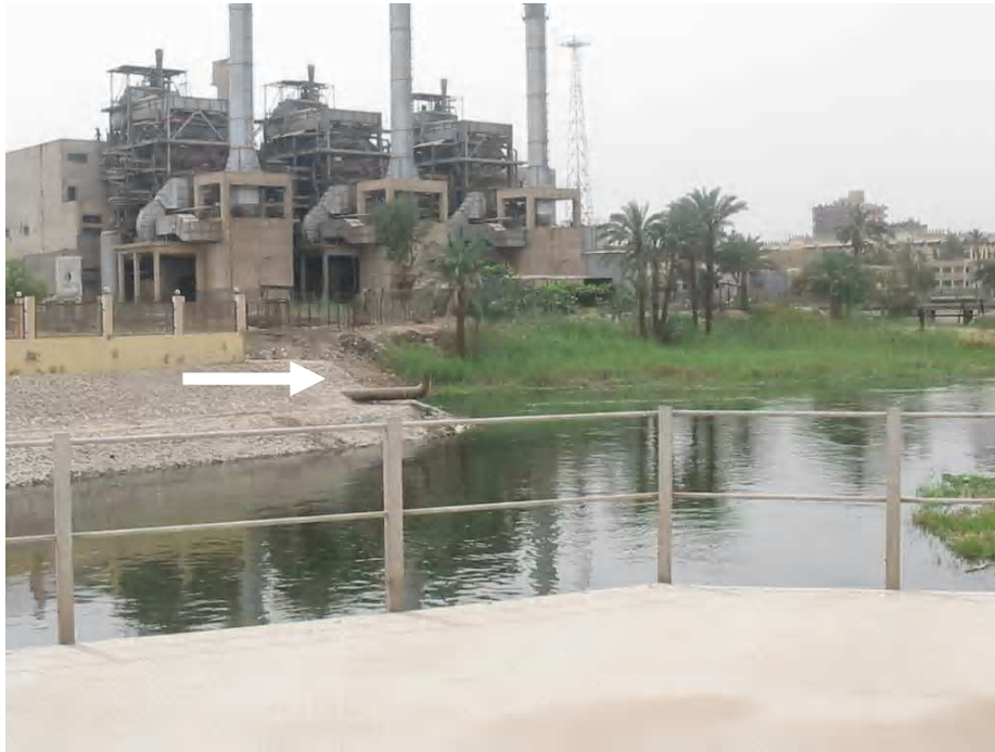
شكل (٥-٢): ماسورة صرف مياه الروبة وغسيل المرشحات بمحطة مياه الشرب بنزلة عبداللاه على النيل. ملاصقة لمحطة كهرباء الحمراء
