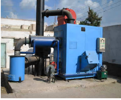
شكل (٦ - ٩): آلة ترميد حديثة (إنتاج مصنع ٤٥) موجودة بمستشفى النساء والولادة بمدينة أسيوط
