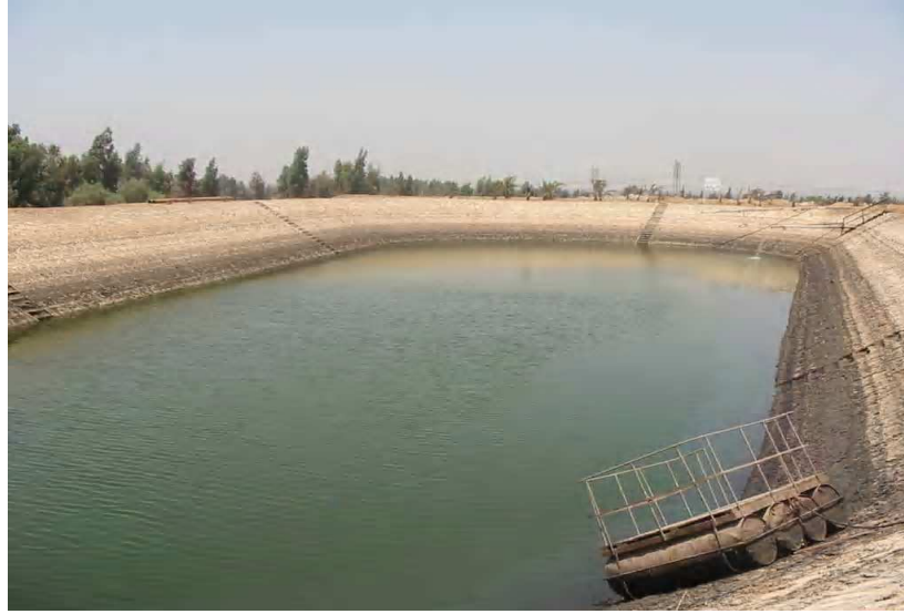
شكل (٤-٧) : بركة معالجة مياه صناعية بشركة أسسيوط لتكرير البترول
